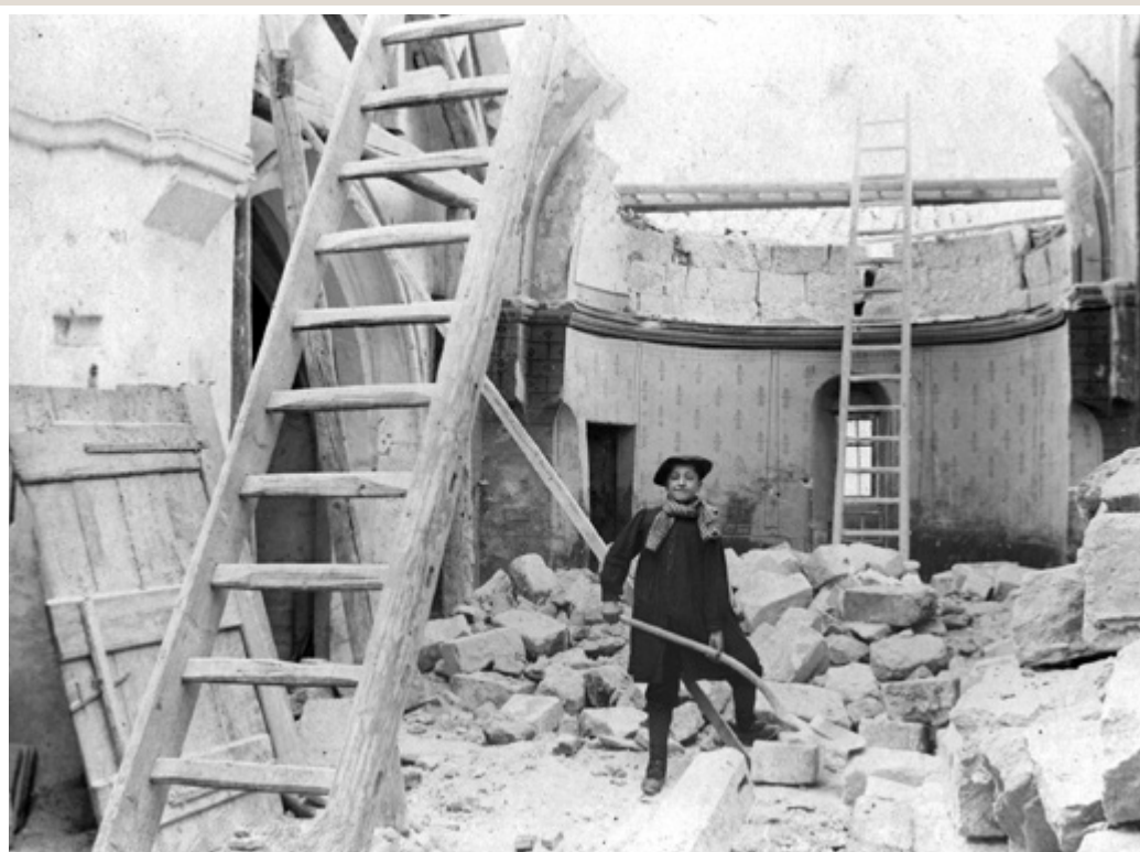
Réfection de l'église Mars 1896 - Louis Mounet
